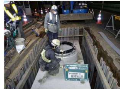
⑯ 埋戻し用砂埋戻し転圧状況
