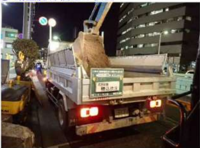
④ 路盤廃材積み込み状況
