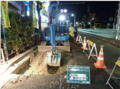
④ 路盤廃材積み込み状況
