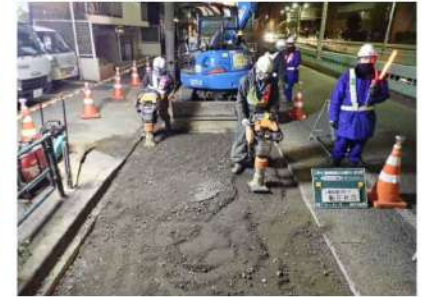
⑲ 仮舗装 基層工転圧状況
