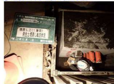
⑯ 埋戻し用砂埋戻し転圧状況
